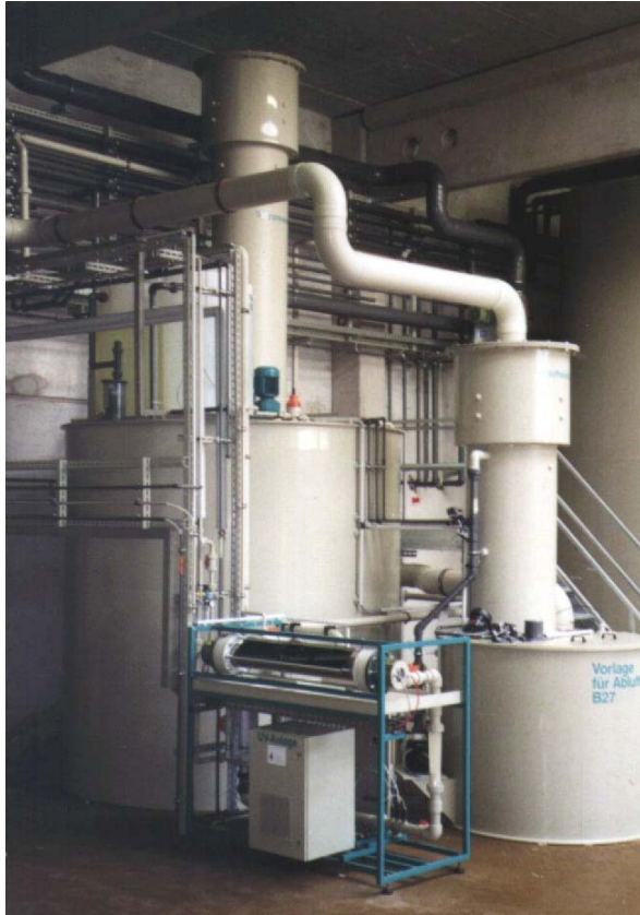
Foto 4: Enviolet® installatie bij Thoma voor de behandeling van afvalwater afkomstig van stroomloos vernikkelen en Zink-Nikkel, zoals in tabel V beschreven. De behandeling vindt plaats in een 12 m 3 batch. Door een volledig automatische sequentiële behandeling worden alle chelaten afgebroken. Niet te zien op de foto is de elektriciteitskast en de doseerstations. De installatie kan gemakkelijk uitgebreid worden tot het drievoud/dag, zonder meer plaats inname.
