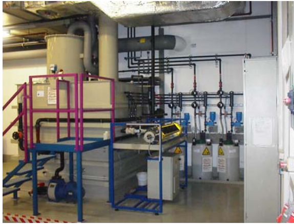
Foto 1: de behandelingsunit voor detoxificatie van Cu-EDTA bij Multek, compleet geleverd en geïnstalleerd door a.c.k.
